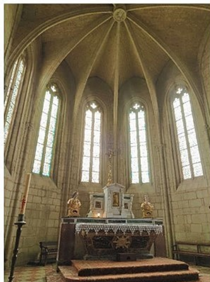
Chœur – Elévations et voûtes en pierre de taille
